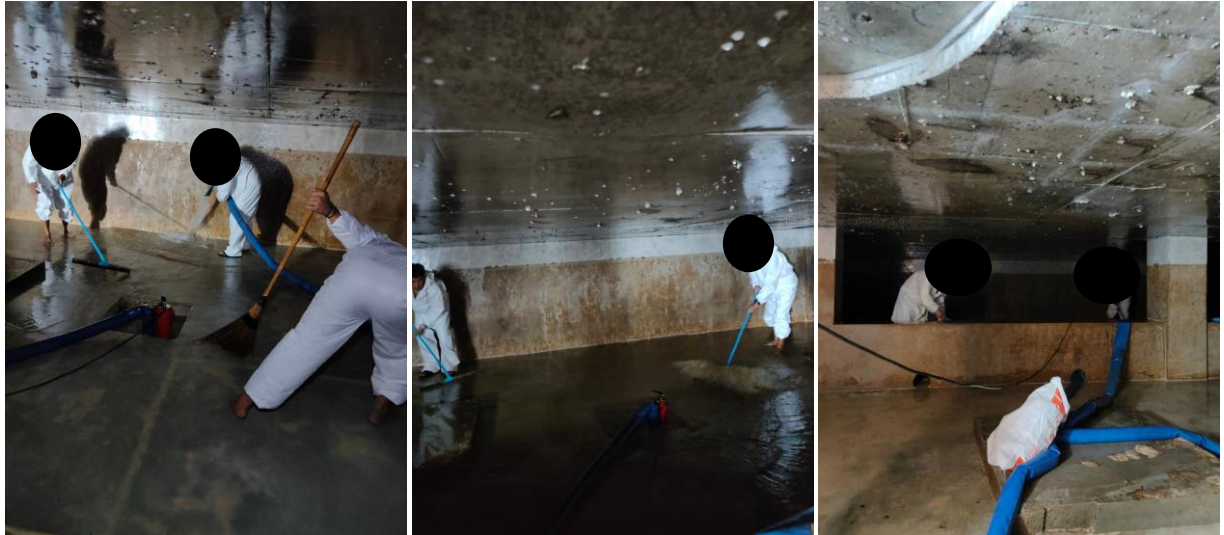
รูปที่ 2-32 ล้างทำความสะอาดถังเก็บน้ำ เมื่อวันที่ 21-23 พฤศจิกายน 2566 ปี 2567 มีแผนในเดือนพฤศจิกายน
